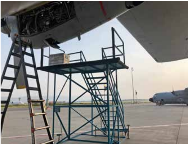
Alle onderhoud en herstellingen van de C-130's gebeurden in open lucht. | Toute la maintenance et les réparations des C-130 étaient effectuées à l'air libre. | © Défense
